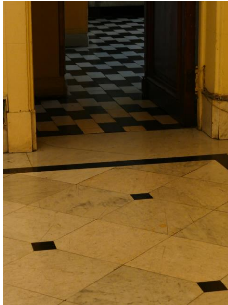
Figura 25: Conservación de transiciones espaciales de vestíbulo del 454 a zonas de servicio, marcadas clásicamente mediante pavimentos nobles (mármol, en primer plano) contra funcionales (baldosa líquida en ajedrezado, al fondo). Fuente: Fotografía Elna von Harpe, 2016.
